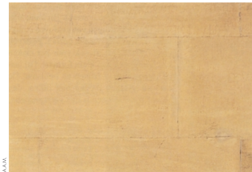
Pierre de Grandcourt : pierres de taille de grand appareil.
