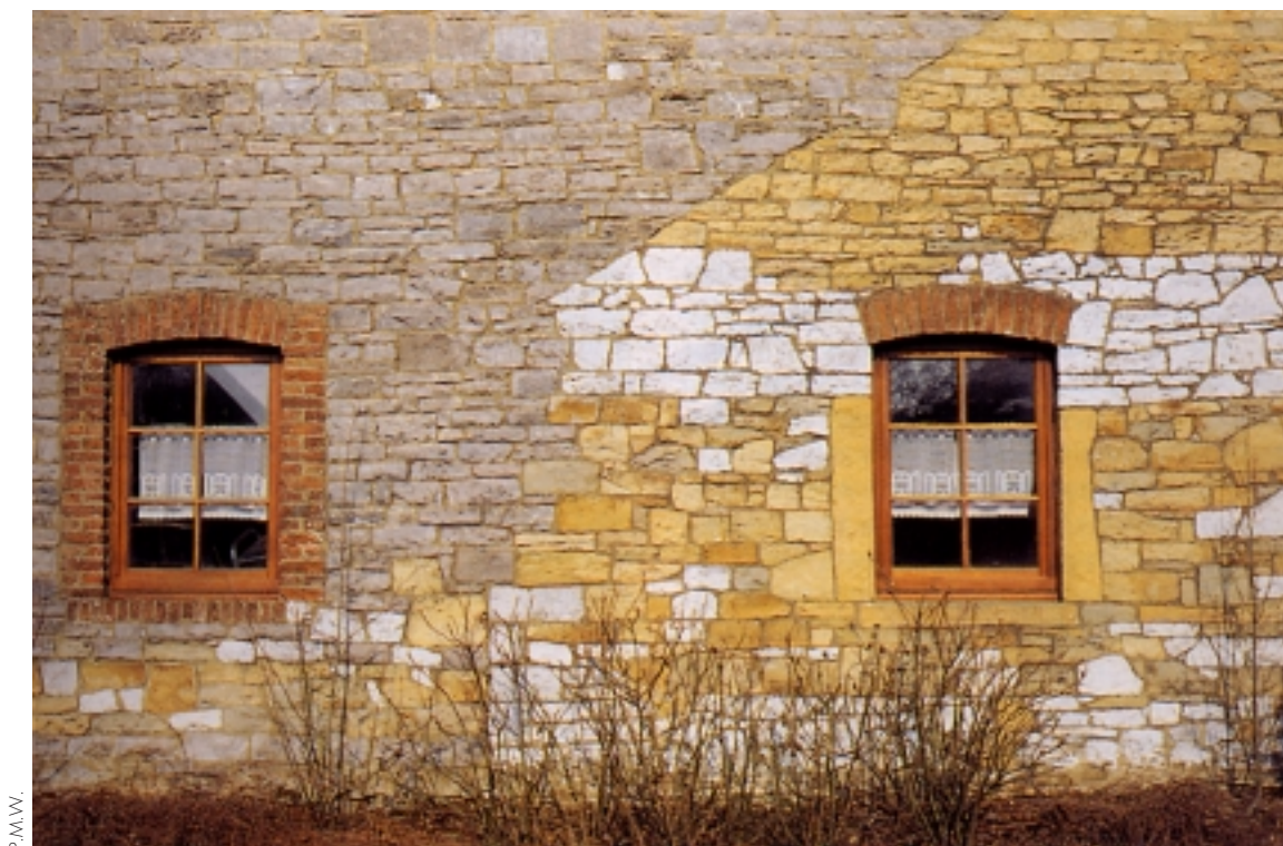
Fig. 18 Maçonnerie en petit granit, en calcaire de Meuse et en grès famennien.
