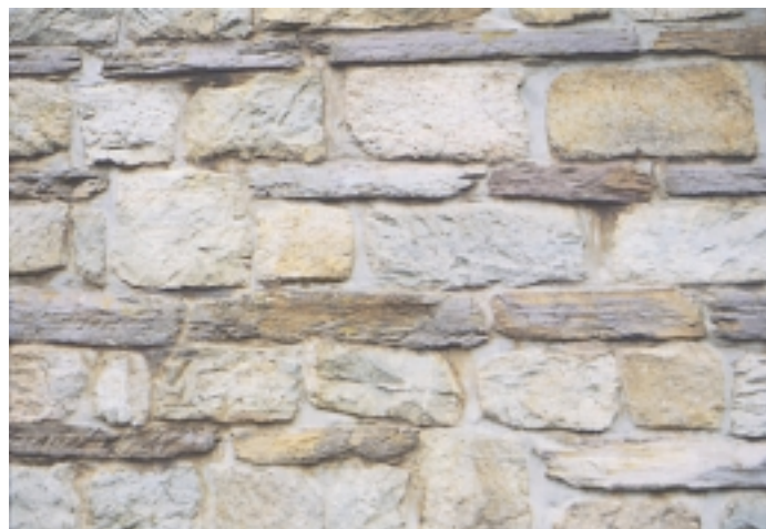
Fig. 20 Maçonnerie traditionnelle en moellons d'arkose de couleurs pastel, avec intercalation d'éléments plats en pierre d'Otré violet. Maison rurale à Jevigné (Lierneux, Ardenne du nord-est).
