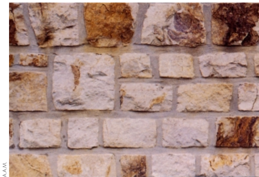
Moellons de quartzite épincés.
