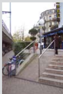
< Rampe avec pente excessive.
