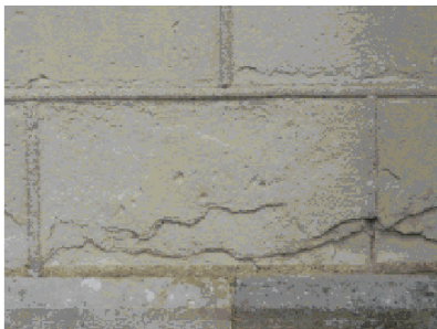
Altération différentielle de la pierre tendre liée à la présence de joints ciments et d'une roche plus dure en partie basse.
