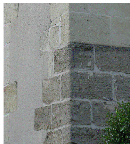
Utilisation du falun d'Anjou en soubassement (pierre plus dure).
